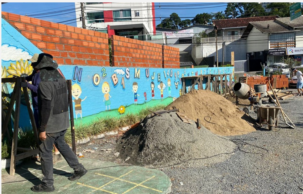
foto: Creche Cantinho Bom Pastor - Blumenau (SC) 2023
