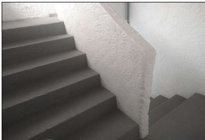
Figura 41 - Acesso ao prédio do laboratório de projetos em automação
