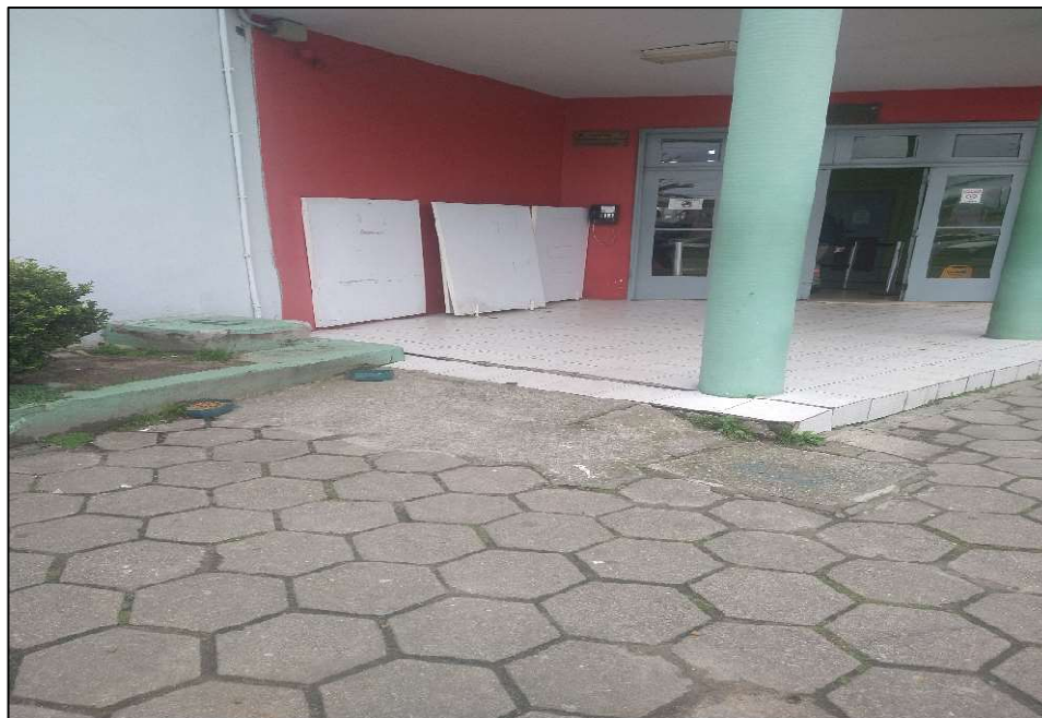
Figura 10 - Rampa de acesso ao pavilhão 01
