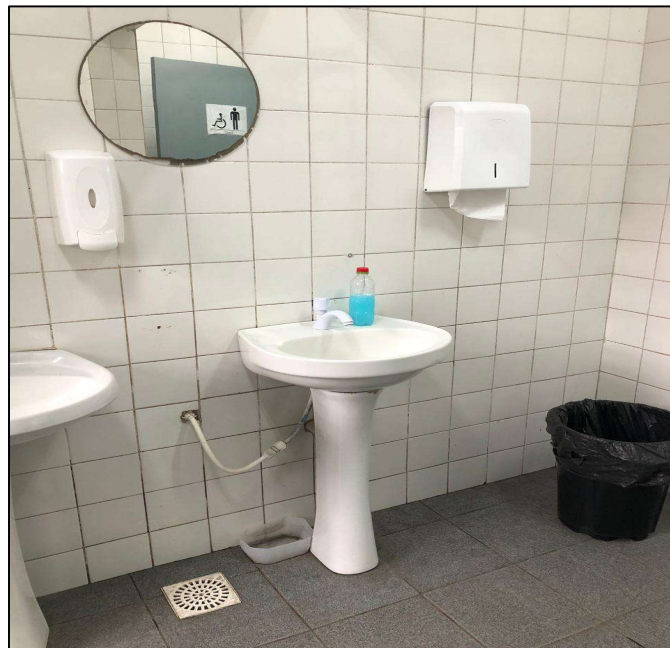
Figura 15 - Pia banheiro acessível pavilhão 2
