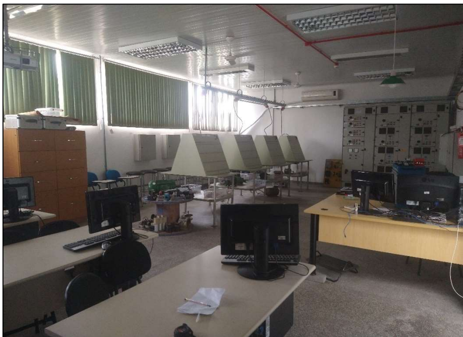
Figura 44 - Vista do laboratório de acionamentos elétricos e industriais
