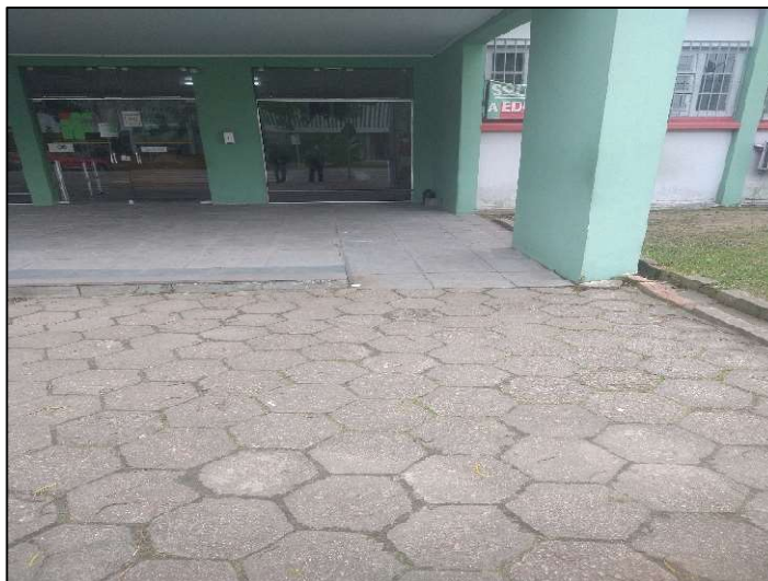
Figura 9 - Rampa de acesso ao pavilhão 2
