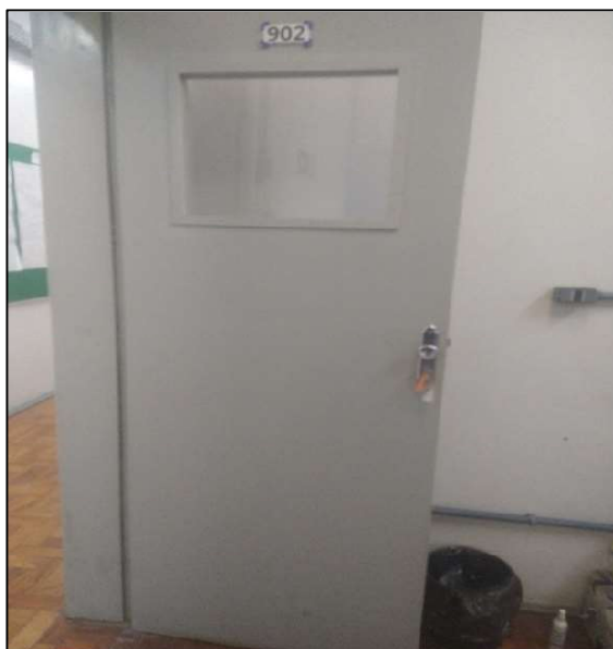
Figura 24 - Porta de entrada laboratório sala 902
