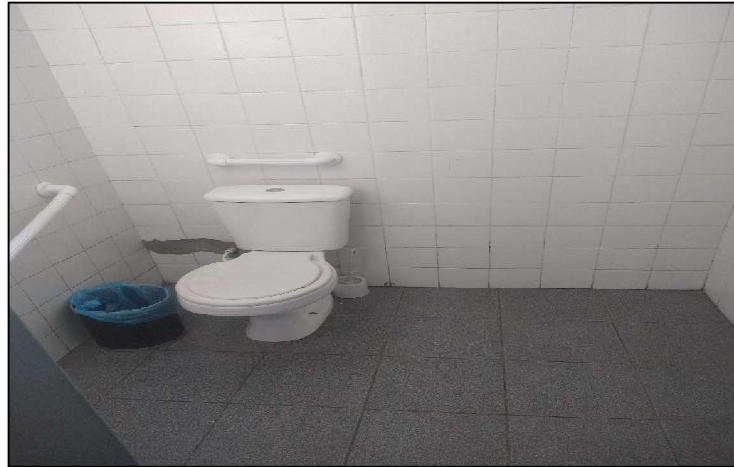
Figura 14 - Vista banheiro acessível pavilhão 2
