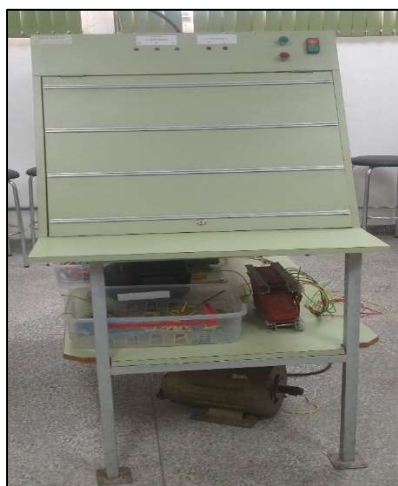
Figura 45 - Conjunto didático laboratório de acionamentos elétricos e industriais
